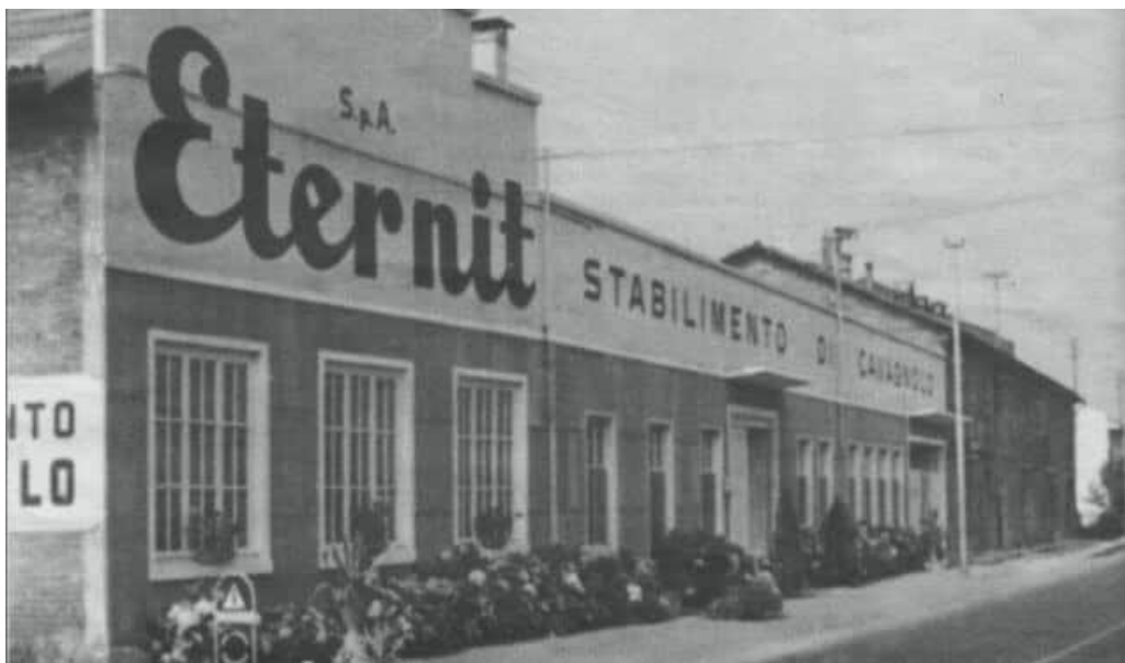
Figura 11: Stabilimento Eternit. ( https://www.spagliarisi.it ).
